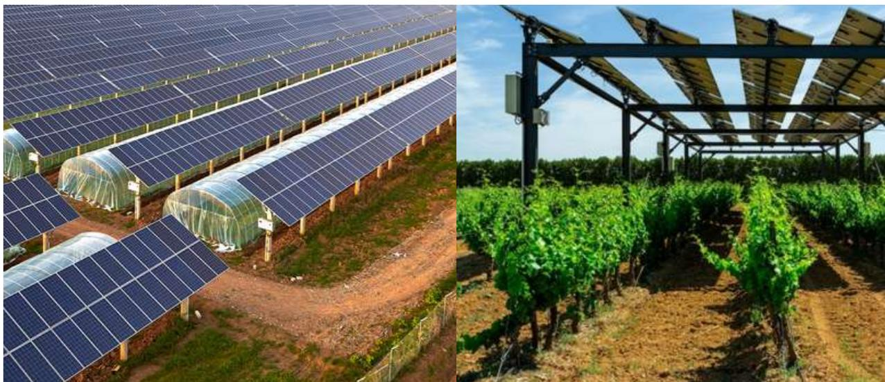
*Une installation agrivoltaïque est une installation de production d'électricité utilisant l'énergie radiative du soleil et dont les modules sont situés sur une parcelle agricole où ils contribuent durablement à l'installation, au maintien ou au développement d'une production agricole (loi d'accélération des EnR) - cf. Décret du 8 avril 2024.*
