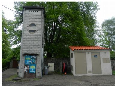
*L'ancien transformateur doit être supprimé et le nouveau à droite est en attente de mise en service.*
