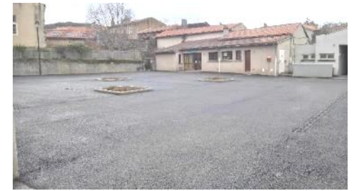
Les travaux réalisés en février 2017
