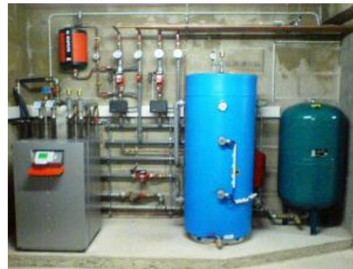
Trois types de pompes à chaleur : air/eau à gauche, ce qui nécessite des équipements importants ainsi qu'une prise d'air extérieure importante. Au milieu, la pompe air/air utilise cette même prise d'air mais nécessite des diffuseurs. L'installation de ces deux équipements est donc difficile à Saint-Saturnin. La pompe à chaleur eau/eau ne nécessite pas de prise d'air, l'équipement doit toutefois pouvoir être placé au sein de l'édifice.
