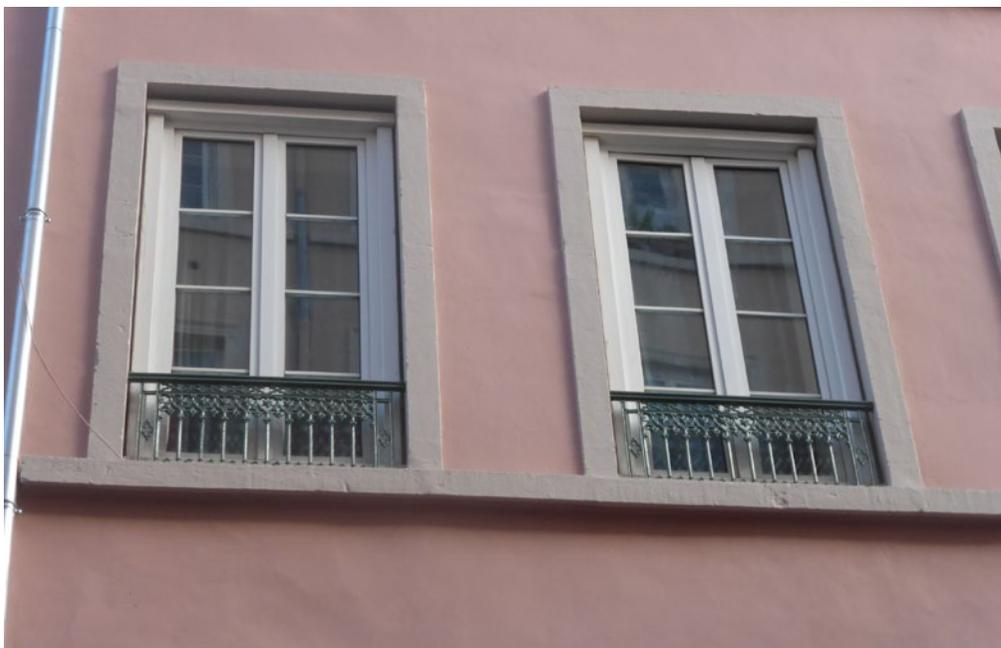
*En haut, une façade isolée par l'extérieur. Le problème du raccordement avec le rez-de-chaussée demeure.
