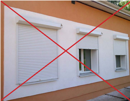
A gauche, des volets roulants blancs et saillants, donc proscrits. A droite, le volet roulant est intégré et de la couleur de la menuiserie.
