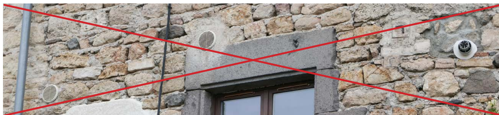
Les surépaisseurs de plus de trois centimètres en façade sont proscrites. De fait, les isolations thermiques extérieures traditionnelles sont impossibles.
