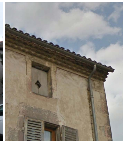
En haut : enduit à pierres vues. Les joints ne sont pas creux et viennent «mourir» sur la surface assisée des pierres. En bas : deux décors peints, qui valorisent les mêmes éléments : chaines d'angles, encadrements de fenêtres, filets soulignant les génoises.
