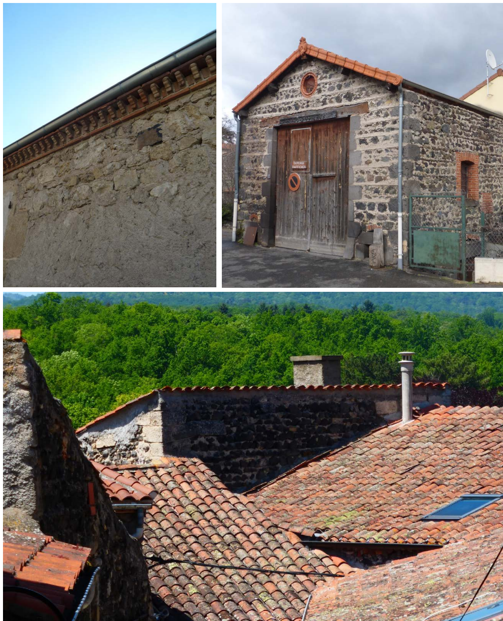
La terre cuite est très présente sur le territoire, car couramment utilisée : encadrements de fenêtres, corniches, tuiles de rives, tuiles. Le caractère peu noble la réserve surtout aux édifices agricoles.
