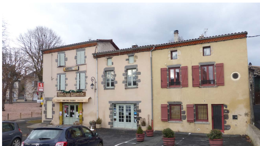
Les façades en moellons de pierre sont souvent enduites. Les chambranles sont en pierre ou en briques, et ils forment avec les génoises les seuls éléments décoratifs. Les chaînages d'angle sont rares.
