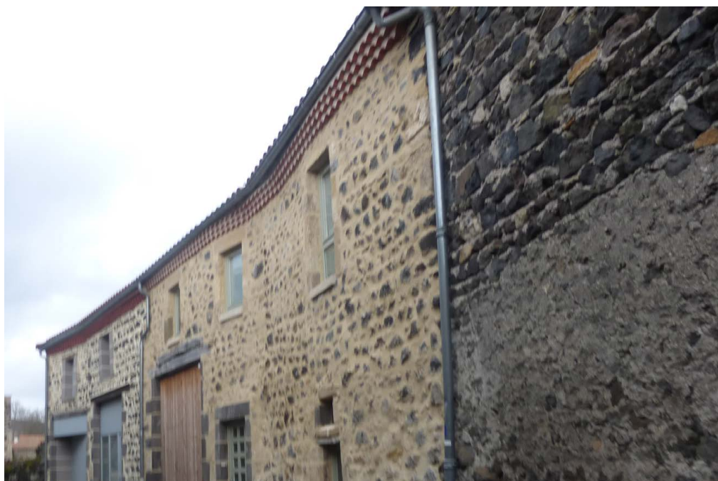
Les génoises en tuiles canal sont omniprésentes à Saint-Saturnin. Elles soulignent de manière délicate les lignes de toit, et s'avèrent à la fois utiles et esthétiques.
