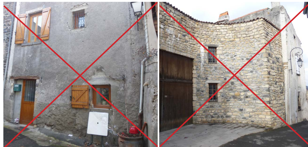
L'usage du ciment (enduits, joints) est totalement proscrit sur les constructions en moellons de pierre, car il peut provoquer d'importantes altérations du bâti.
