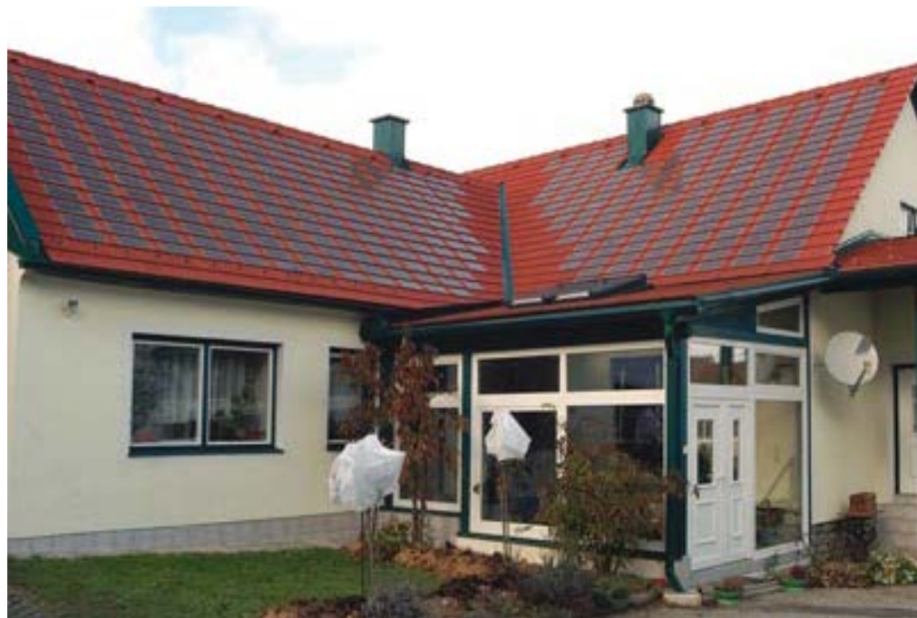
Les tuiles solaires permettent une intégration plus facile au bâtiment, le «module» étant plus petit. Elles demeurent toutefois visibles dans le paysage.
