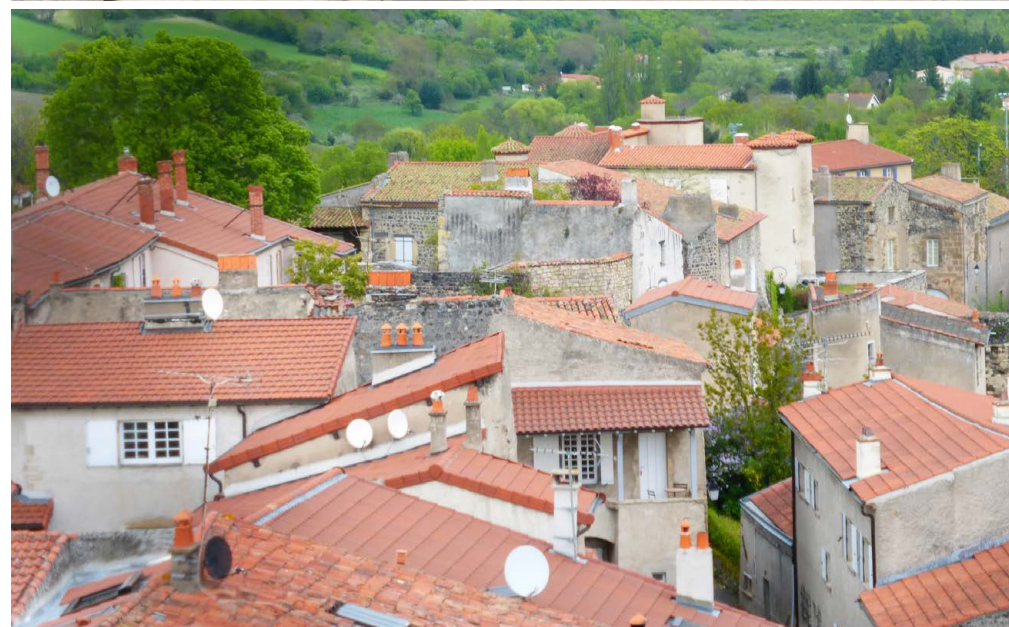
Les volumes des toitures saturninoises sont extrêmement simples, car majoritairement à simple ou double pan. Les pans coupés, les toitures complexes, sont rares.
