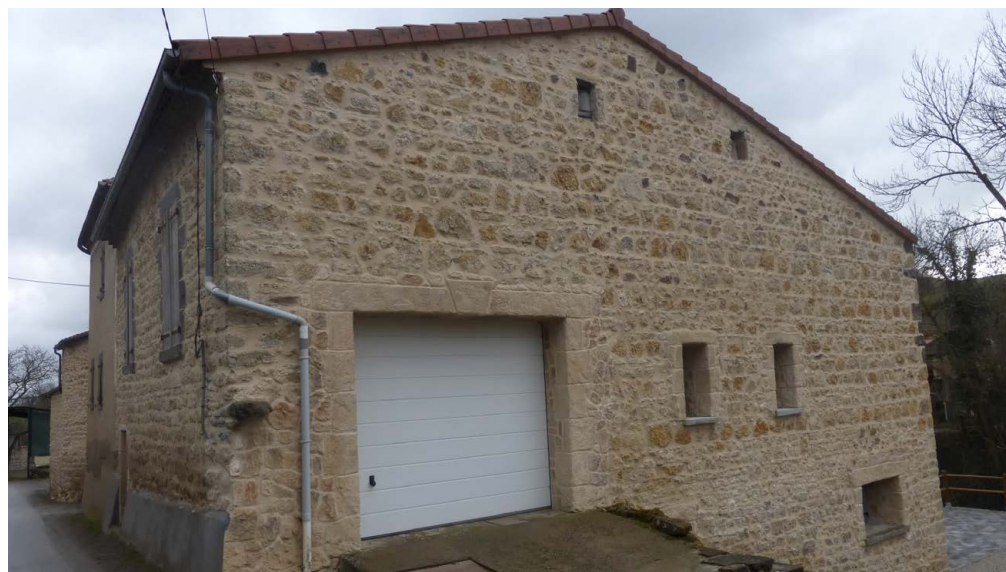
Différents enduits couvrants (haut à gauche) ou à pierre vue (en haut à droite.) Les édifices non enduits (en bas) sont également très présents, les joints doivent alors être généreusement dimentionnés.
