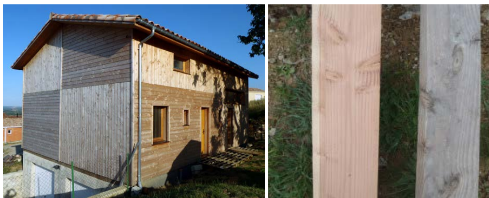
Le vieillissement du douglas : à gauche, un an après la pose. À droite, planche neuve et trois ans après. Le mélèze est un bois devenant gris également.
