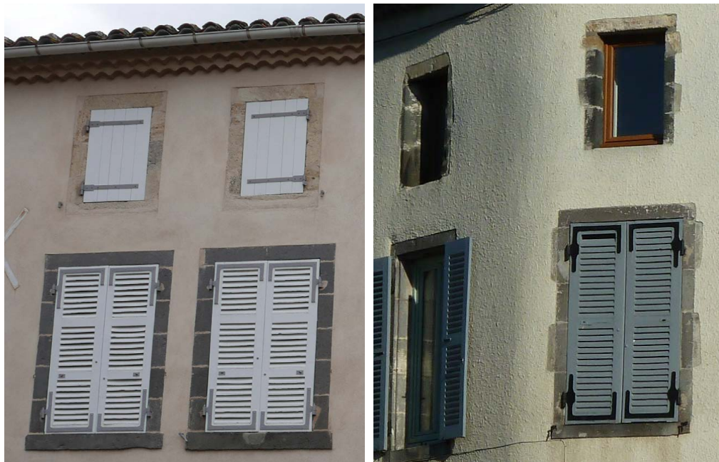
En haut, quatre fenêtres traditionnelles (encadrement en harpage, qualité et découpage des menuiseries). En bas, l'enduit régularise l'encadrement de la fenêtre. A droite, on voit d'ailleurs apparaître, par transparence, la volumétrie complète des pierres.
